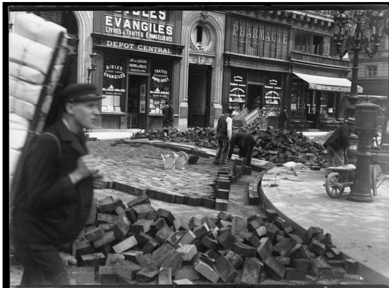
plaque négative au gélatino-bromure d'argent, format 9x12 cm. inscription sur enveloppe : "Paris : place du théâtre français atelier de pavage en bois Mai 1902 app. Zion pl. jougla"
